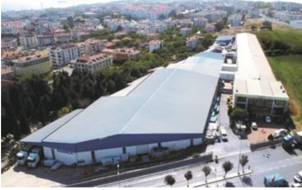
Beylikdüzü Boru Fabrikası
