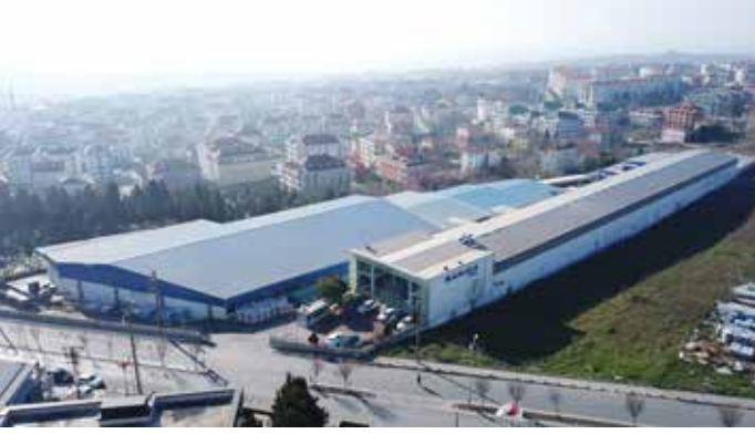
Beylikdüzü Boru Fabrikası
