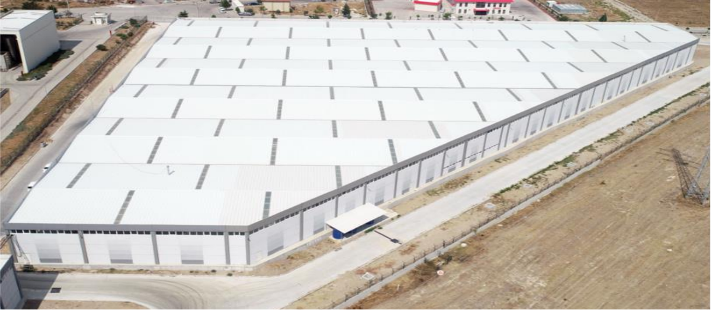
Kombi Tesisi Görünümü
