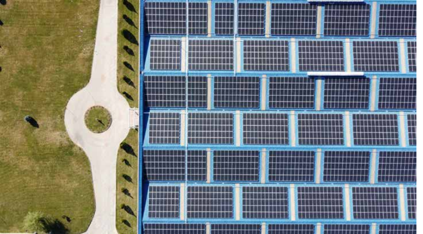
Elazığ Boru Fabrikası
