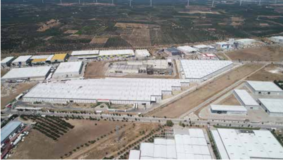
Radyatör Tesisi Görünümü
