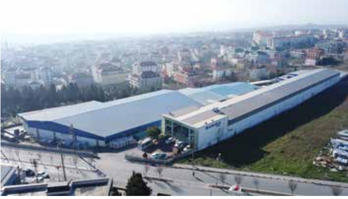
Beylikdüzü Boru Fabrikası
