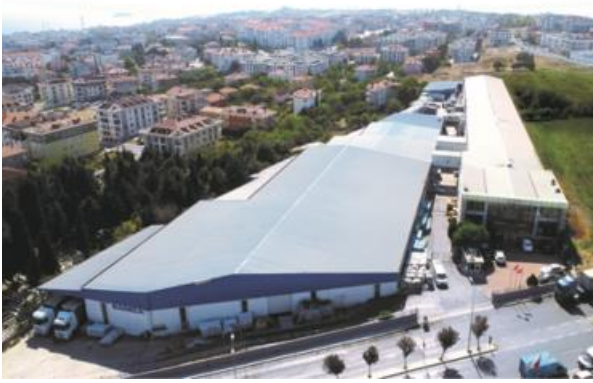
Beylikdüzü Boru Fabrikası
